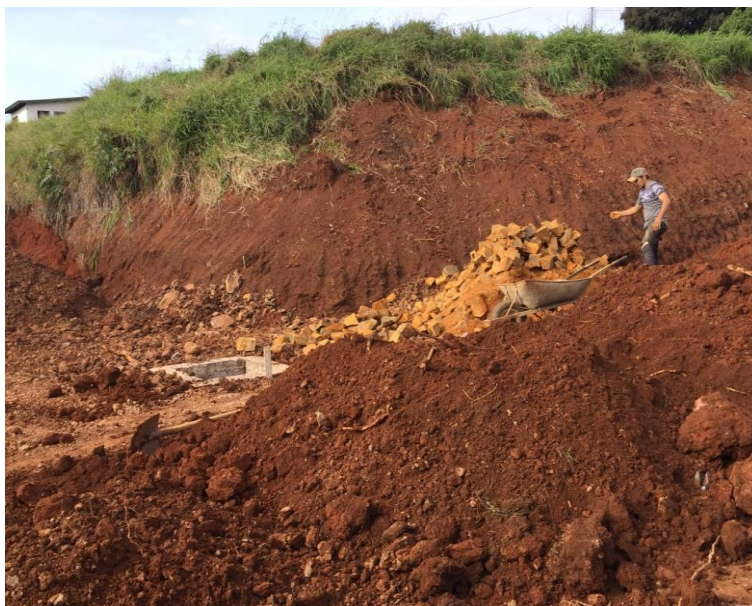
Figura 9 - Implementação da rede de drenagem das águas fluviais do município.
