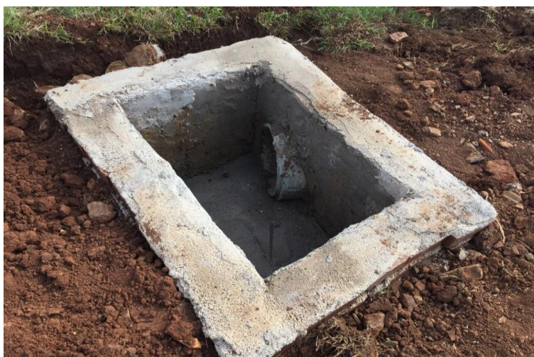
Figura 10 - Caixa coletora de água da rede de drenagem das águas fluviais do município.
