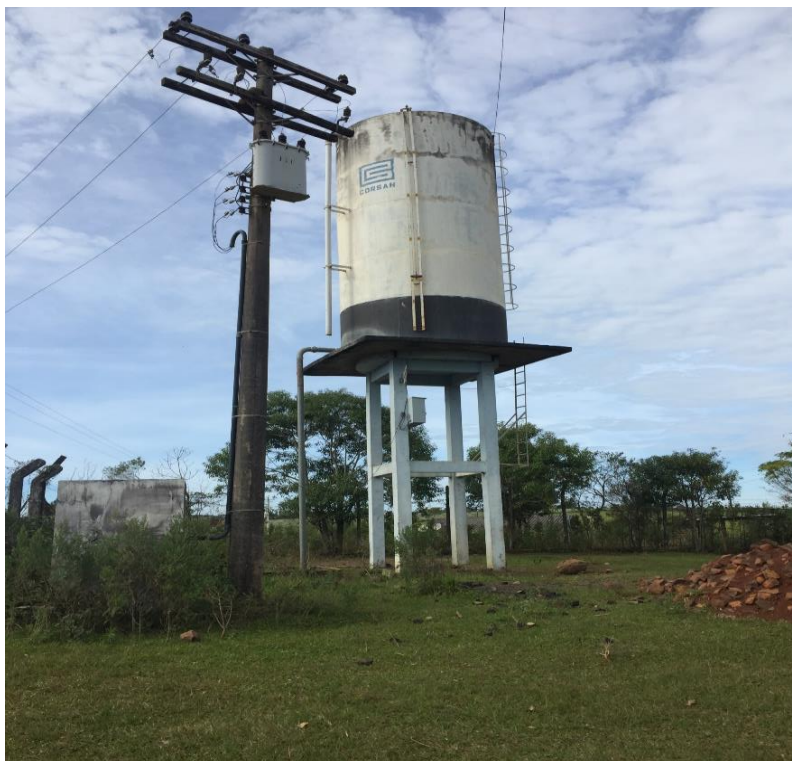
Figura 6 - O sistema de reservação de água no município de Faxinalzinho.
